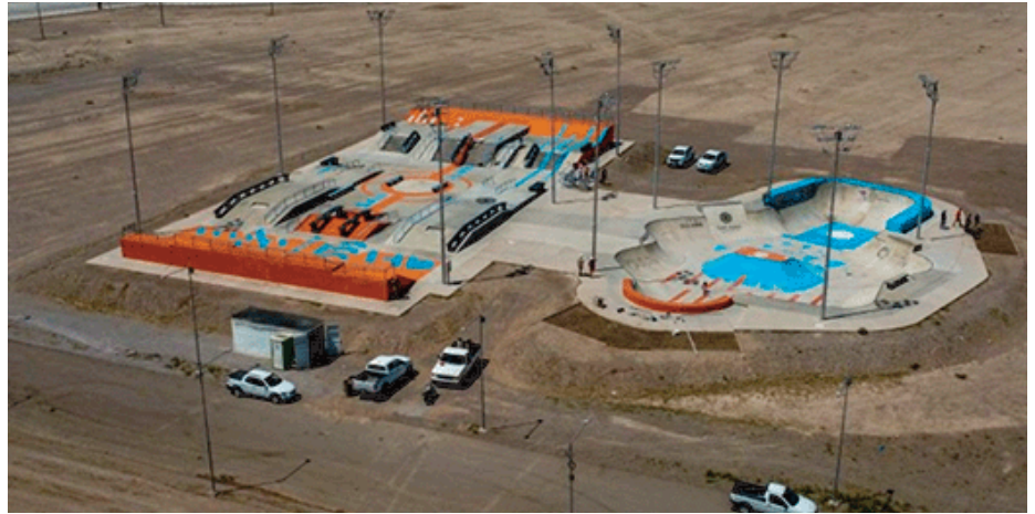
Los equipos avanzan con el montaje de estructuras, instalación de cableado, iluminación, cierres perimetrales y preparación de stands para el evento.
