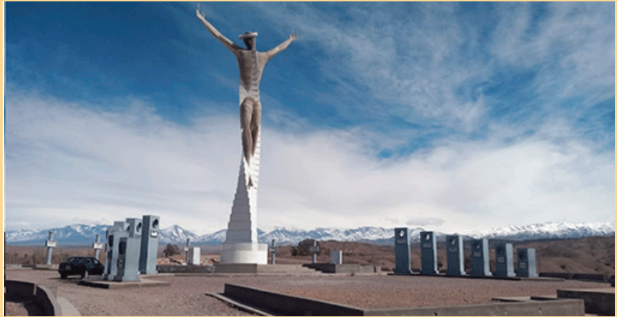
La empresa que estuvo a cargo del Cristo de la Misericordia reclama ahora que le terminen de pagar los trabajos, lo que no estaba en las cuentas de Carbajal.
