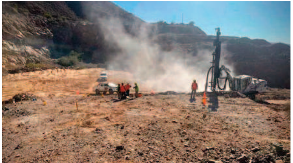
En el Túnel de Zonda se llevaron a cabo el año pasado voladuras y despeje de la zona.
