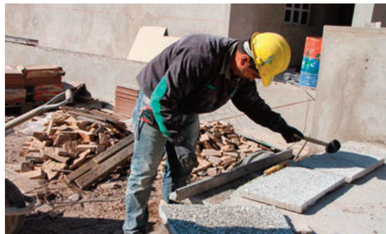
La construcción en la provincia, en lo que respecta a obra pública, está paralizada y con muchos trabajadores en la calle.
