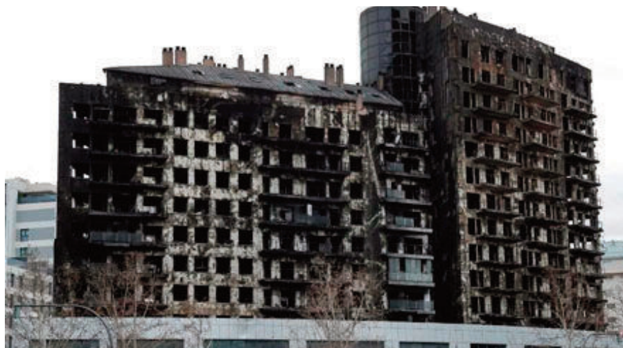
Las dos torres incendiadas en Valencia
