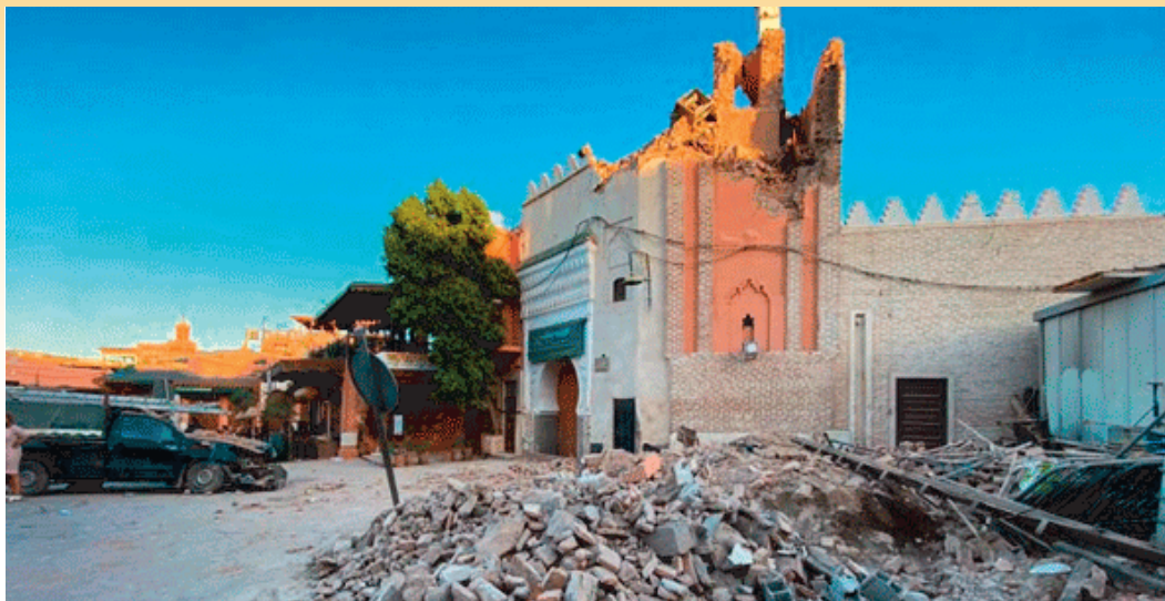
Una vista muestra los daños en una antigua mezquita de la histórica ciudad de Marrakech, tras el fuerte terremoto que sacudió Marruecos, el 9 de septiembre de 2023.
