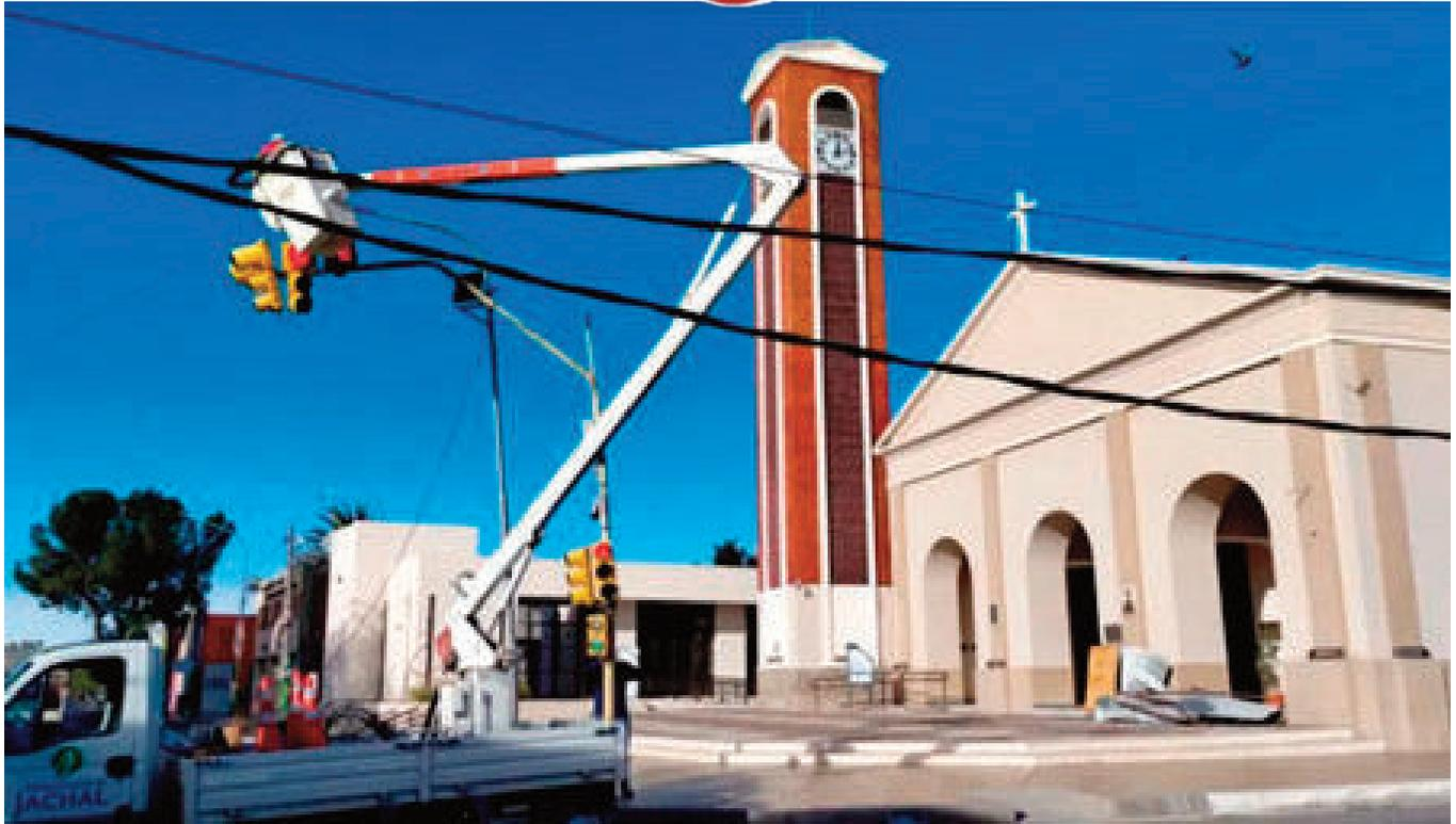
Una grúa trabaja en la reconexión de cables y la reposición de luminarias.
