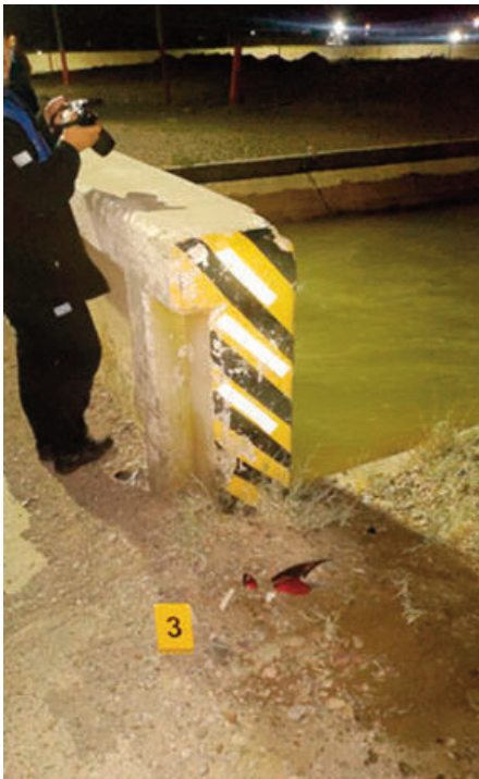
El conductor de una moto cayó al canal luego de chocar con el muro de contención del canal. Lo sacaron muerto.
