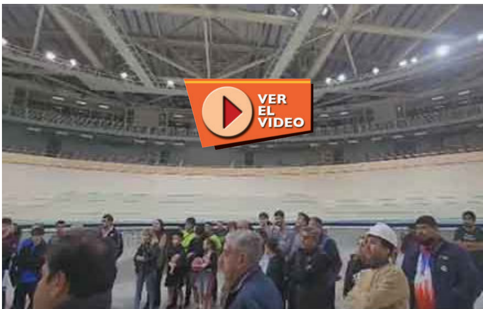
Este video de 360 grados permite ver en su magnitud la obra.
