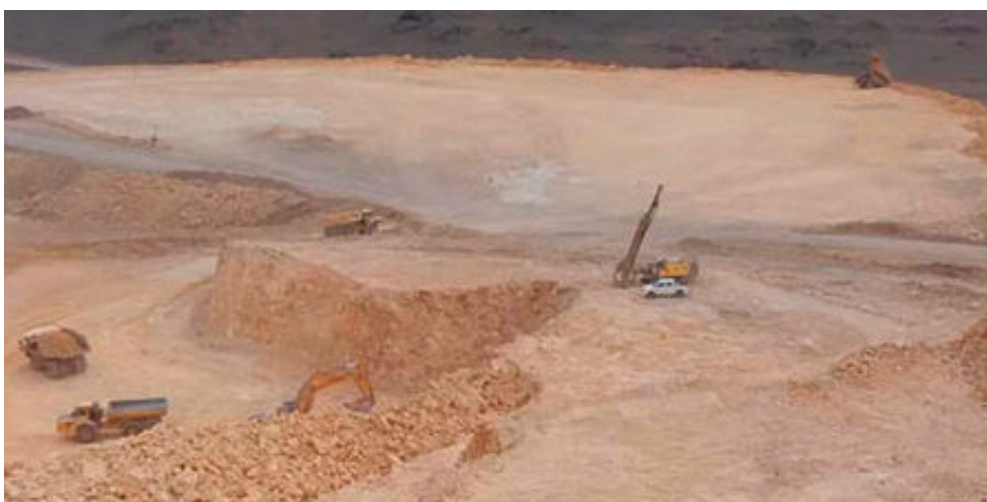
Una foto de los trabajos en el lugar.
