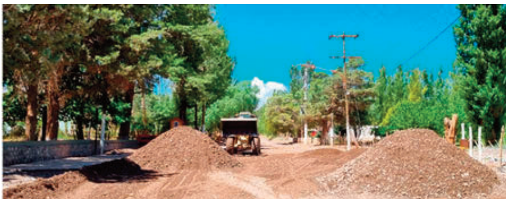
Las máquinas ya están trabajando en Barreal.
