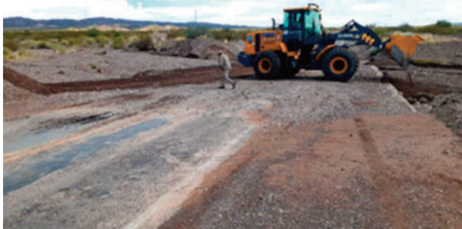
Equipos de Vialidad trabajando en la zona del Villicum
