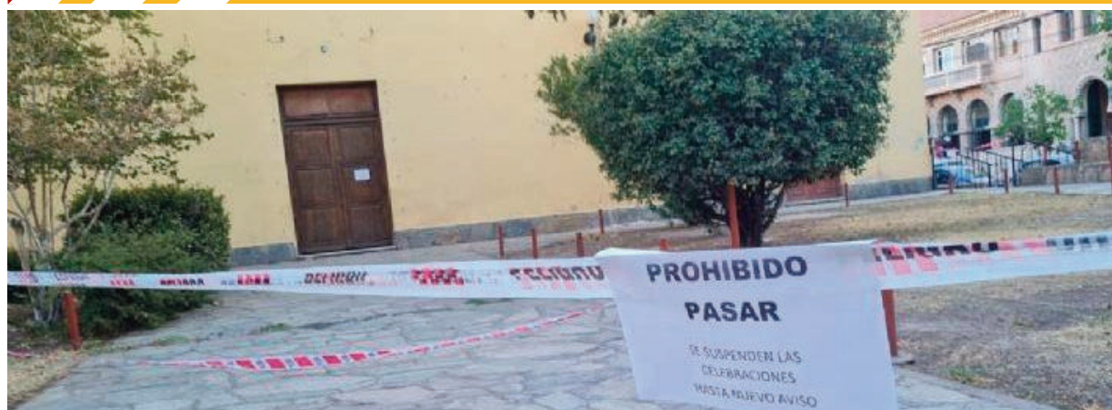
Iglesia de Santo Domingo dañada por el terremoto del 18 de enero.
