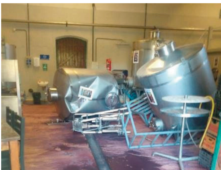
En la bodega Las Marianas, en Pocito, se produjeron importantes daños.
