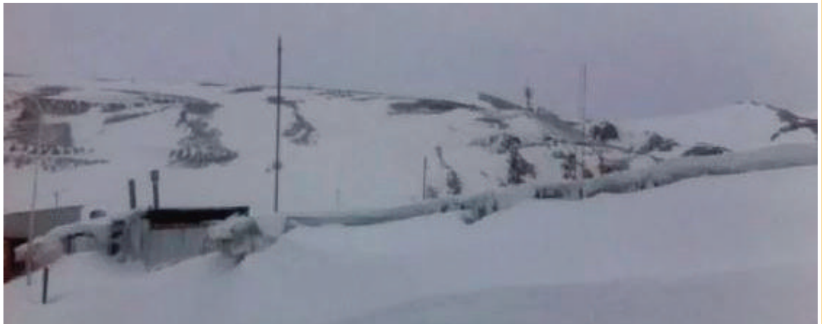
Veladero tapado por nieve
